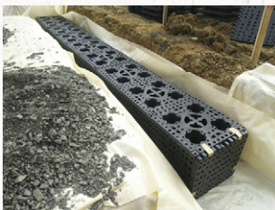
5 スーパージオ®材を 設置します。
