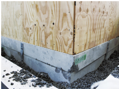
無対策実験 日立波で崩れた基礎
