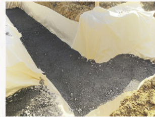
3 砕石を敷き 転圧を行います。
