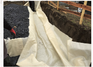
4 再び土木シートを 敷きます。
